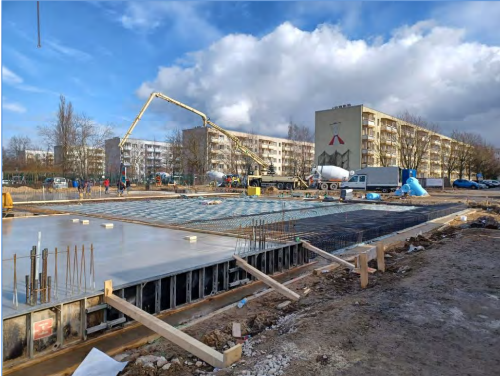
Abbildung 2: Fundamentarbeiten Sporthalle III
