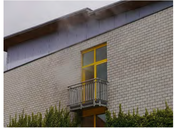
Abbildung 51 Die gezielte Rauchableitung mittels einzelner geöffneter Fenster und unterstützender Drucklüfter dient der Wiederherstellung der Rauchfreiheit in den notwendigen Fluren. Somit werden die bekannten baulichen Rettungswege wieder nutzbar.
