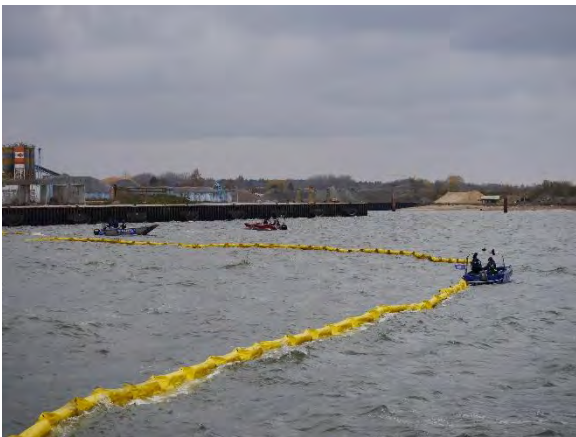
Abbildung 25 Die rund 100 m lange „Ölsperren-Schlange“ galt es mit den drei Booten zu bändigen und – unter Ausnutzung der Strömung – in die richtige Position zu bringen.
