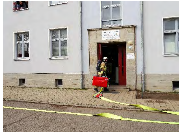
Abbildung 15 Die ersten Einsatzkräfte unter Atemschutz betreten mit ihrer Ausrüstung das Gebäude.
