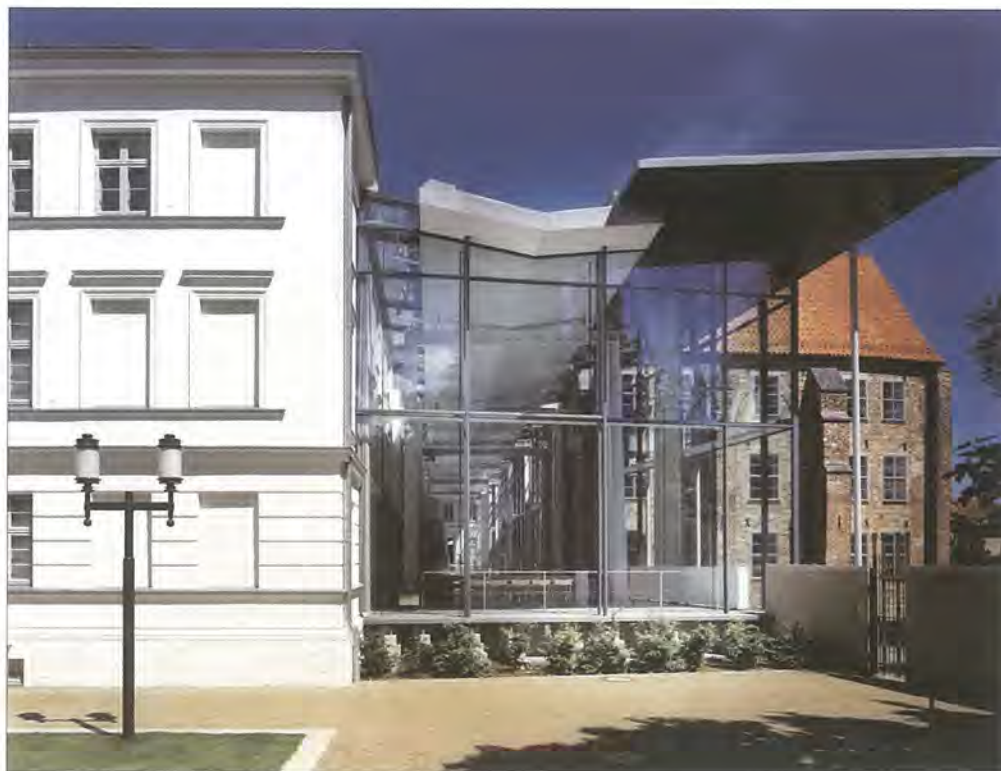
Abb. 2 Ein weiträumiger Glasbau verbindet die historischen Gebäude. Links das als Altersheim gebaute „Graue Kloster“, rechts die um 1500 errichtete Klosterbibliothek des ehemaligen Franziskanerklosters. Im Kopf des Glasbaus das Tagungszentrum mit Blick auf die Wallanlagen. Foto: Armin Wenzel
