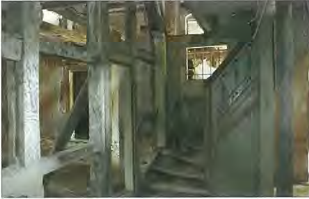
Abb. 14 Entkernte Fachwerkwände des 18. und 19. Jhs. sowie Treppenanlage der 1820er(?) Jahre. Blick nach Osten. Foto: T. Rütz (1991)
