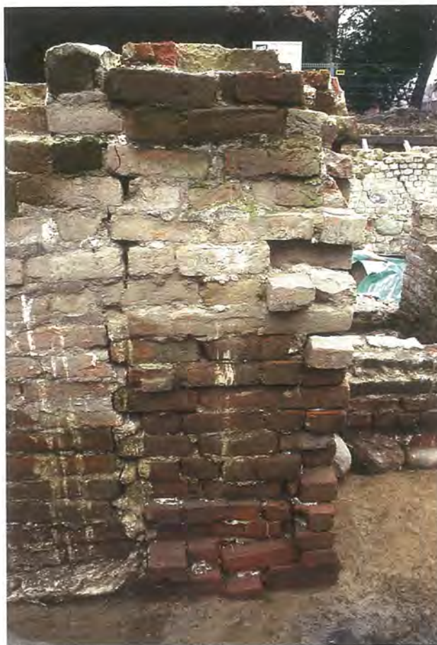
Abb. 9 Hanse- und Universitätsstadt Greifswald, Kellergeschoss, Grenzmauer zwischen den Grundstücken Domstraße 23 und 24, südliche Mauerstirn, von Süden. Am südlichen Mauerkopf des (nur!) zweieinhalb Stein dicken Mauerzuges war lediglich nach Westen eine zwei Stein breite Stehende Zahnung für einen Rückfassadenanschluss ausgeführt. Damit entsprach diese Mauer nicht den Festlegungen für eine Brandmauer nach Lübecker (Bau-) Recht, und markierte demzufolge zunächst auch keine Grundstücksgrenze. Foto: A. Lutze (1995)
