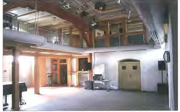
Abb. 15 Der durch die Sanierung entstandene Dielenraum ist dem Zustand vor dem Innenausbau der 1820er Jahre angenähert. Blick nach Westen. Foto: T. Rütz (2005)
