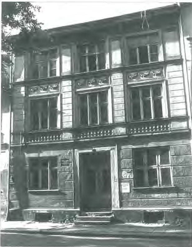
Abb. 2 Hanse- und Universitätsstadt Greifswald, Domstraße 23. Das zweite Obergeschoss entstand im Zuge einer Aufstockung während der 2. Hälfte des 19. Jahrhunderts. Foto: T. Rütz
