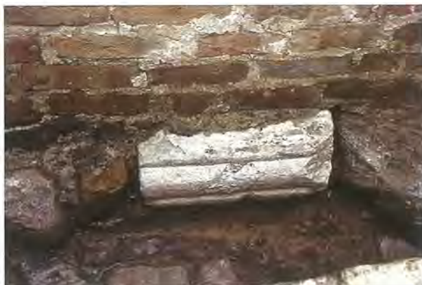
Abb. 15 Hanse- und Universitätsstadt Greifswald, Domstraße 24, südlicher Kellerbereich, Rückfassade des 16. Jahrhunderts, Detail der Gründung, von Süden. Im Fundament der chronologisch dritten Rückfassade war eine bemerkenswerte Spolie verbaut: Die Südseite eines bearbeiteten Kalksteinblockes zeigte eine horizontale Stabprofilierung, wie sie am Kalksteinsockel des um 1385/90 errichteten Chores der nahe gelegenen St. Nikolaikirche in identischer Form ausgeführt worden war. Wann genau und warum dieser Stein ins Fundamentmauerwerk gelangte, konnte bisher nicht geklärt werden. Foto: A. Lutze (1995)
