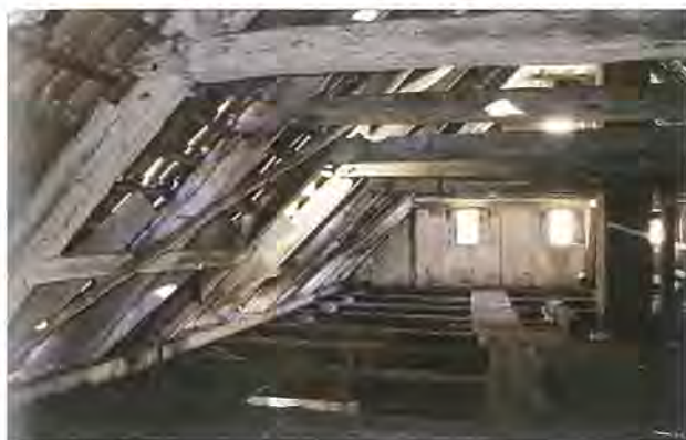
Abb. 11 Dachwerk aus der Sanierungsphase von 1686 (d). Blick nach Osten. Foto: T. Rütz (1994)
