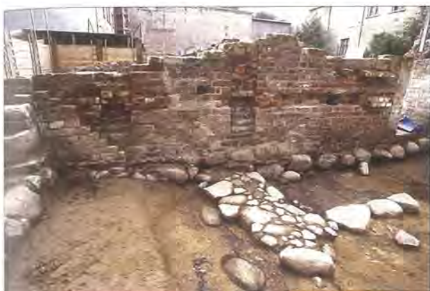
Abb. 14 Hanse- und Universitätsstadt Greifswald, Domstraße 24, südlicher Kellerbereich, Rückfassade des 16. Jahrhunderts, von Norden. Nach Abnahme einer im Jahre 1773 zur Wölbungsvorbereitung vorgeblendeten halbsteinigen Mauerschale wurden große Teile der ursprünglichen und im Wechselverband ausgeführten Mauerwerksoberfläche des 16. Jahrhunderts sichtbar. Die Mauer war darüber hinaus durch zwei schmale und nach Süden ausgerichtete Kellerlichtschächte gegliedert (Mauermitte und links im Bild, obere Bereiche jeweils noch zugesetzt). Im Vordergrund ist die möglicherweise noch im 13. Jahrhundert ausgeführte Feldsteinfundamentierung einer Baustruktur unbekannter Funktion erkennbar, die (spätestens) durch das Mauerwerk des 16. Jahrhunderts überlagert wurde (siehe auch Abb. 5 und 8). Foto: A. Lutze (1995)
