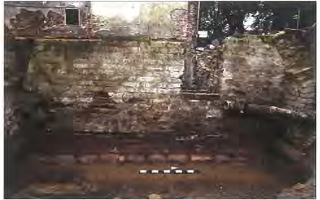
Abb. 6 Hanse- und Universitätsstadt Greifswald, Domstraße 24, Kellergeschoss, westliche Grenzmauer, nördlicher Abschnitt, von Osten. An der um 1300 auf der heutigen Grundstücksgrenze Domstraße 23/24 errichteten Mauer konnten keine ursprünglichen Gliederungselemente wie Nischen oder Blenden nachgewiesen werden. Die im südlichen Abschnitt (siehe Abb. 1) erkennbare Nische ist ebenso nachträglich eingebracht worden wie der hier sichtbare Luftschutzdurchbruch des 20. Jahrhunderts (rechts). Ganz rechts ist der Ansatz des Tonnengewölbes, das hier im Jahre 1773 ausgeführt wurde, erkennbar. Foto: A. Lutze (1995)
