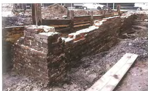
Abb. 10 Hanse- und Universitätsstadt Greifswald, Domstraße 25, Kellergeschoss, östliche Begrenzungsmauer der Kelleranlage von um 1300 mit dem westlichen Abschnitt der zugehörigen Rückfassade (links), von Südosten. Der eineinhalb Stein dicke Mauerzug war unregelmäßig gegen den östlich anschließenden (hier jedoch bereits abgegrabenen) anthropogenen Schichtblock des 13. Jahrhunderts gemauert und nur nach Westen für eine Kellernutzung vorbereitet. Nach Süden ist er nachträglich mit dem bereits vorhandenen Mauerwerk der Rückfassade verzahnt. Foto: A. Lutze (1995)
