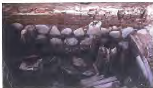
Abb. 2 Hanse- und Universitätsstadt Greifswald, Steinbeckerstraße 1. Strukturen der mittelalterlichen Holzbebauung und Gründung des Anbaus. Foto: P. Kaute
