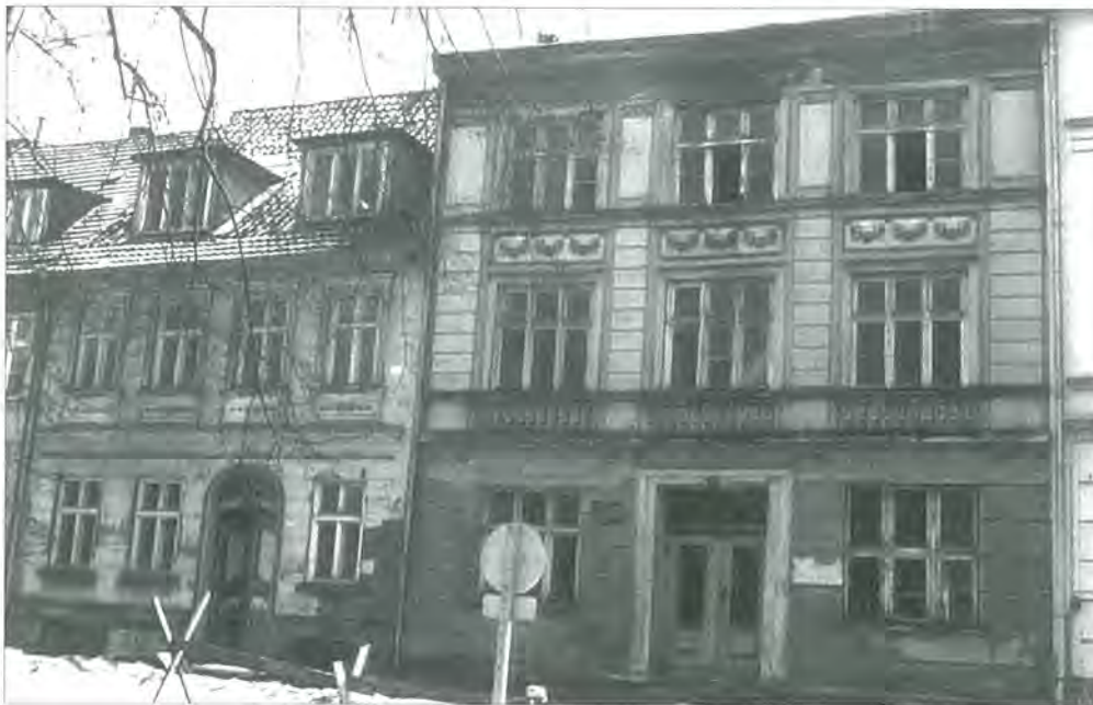
Abb. 1 Hanse- und Universitätsstadt Greifswald, Domstraße 23 und 24, Vorderfassaden beider Häuser in den 1980er Jahren. Foto T. Rütz
