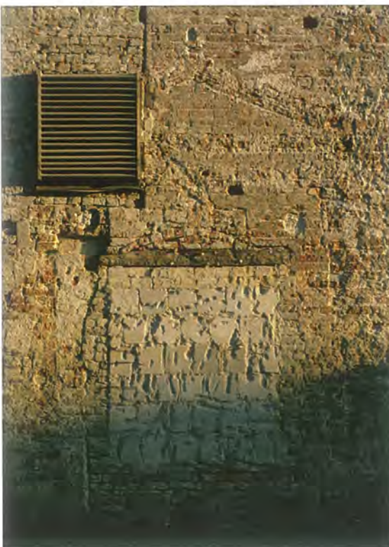
Abb. 7 Im Streiflicht ist die im 19. Jh.(?) abgearbeitete Struktur des zweiten renaissancezeitlichen Portals der Nordfassade erkennbar. Foto: T. Rütz (1995)
