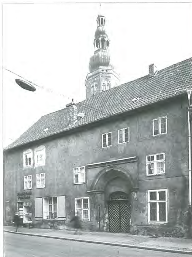
Abb. 1 Nordfassade des Hauses um 1970. Die Größe und Verteilung der Fenster- und Türöffnungen entspricht weitgehend dem Zustand nach den Umbauten der 1820er Jahre. Foto: J. Fritz, Landesamt für Denkmalpflege Mecklenburg-Vorpommern
