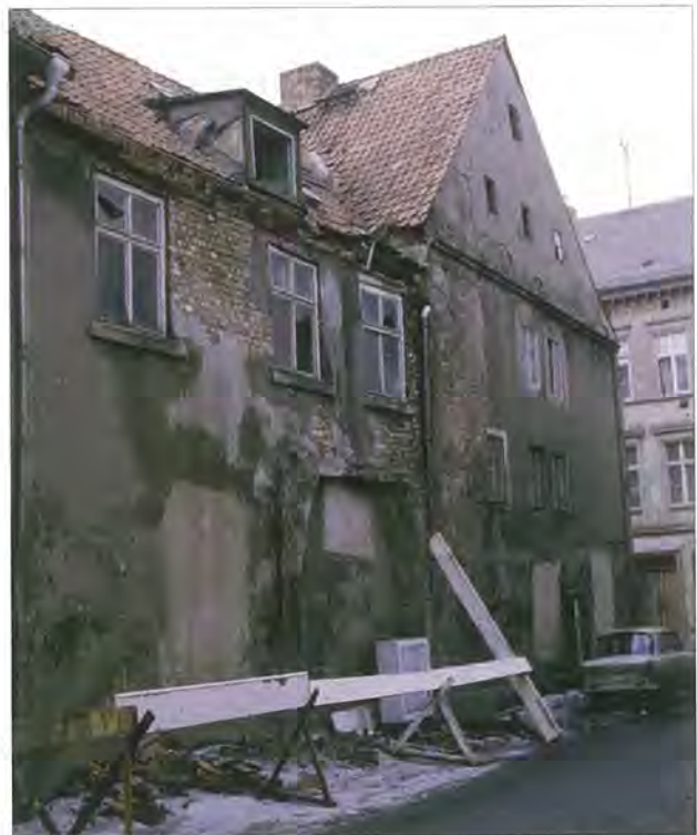
Abb. 2 Ostgiebel und Seitenflügel am Ende der 1980er Jahre. Der bis zur Sanierung vorhandene schlichte Giebelumriß am Haupthaus entstand im 19. Jh. In der Bildmitte ist das zugesetzte und in den Seitenflügel integrierte mittelalterliche Kirchenportal erkennbar. Blick nach Nordosten. Foto: T. Rütz
