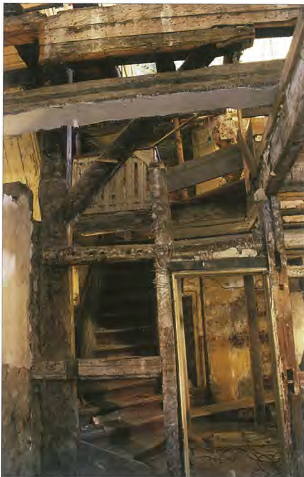
Abb. 9 Greifswald, St. Spiritus, Östlicher Hausbaum von 1611(d). Blick nach Süden. Foto: T. Rütz (1994)
