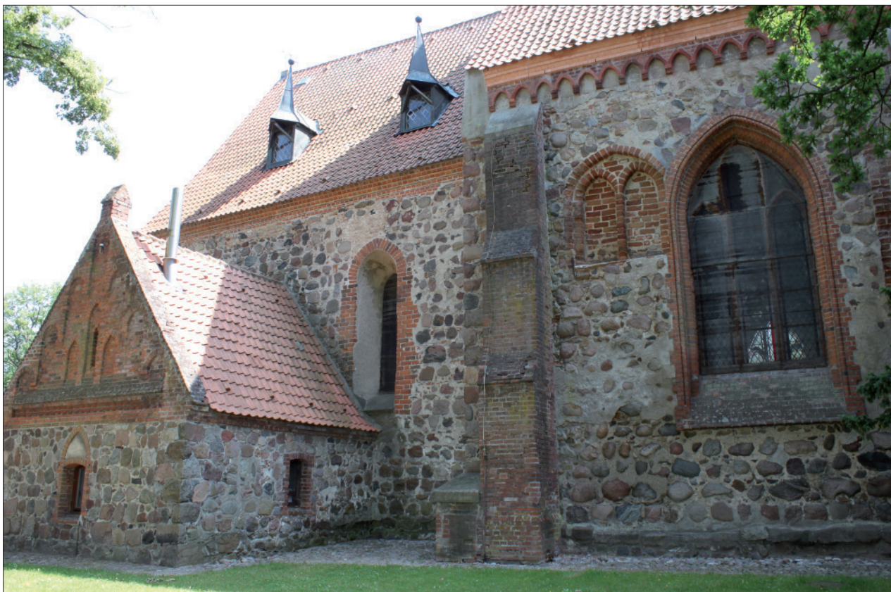
Abb. 2 Gützkow, Stadtkirche St. Nikolai von Nordwesten. Die ältesten Mauerteile des Chores, der nördlich angebauten Sakristei (beides linke Bildhälfte) und des westlich angrenzenden Langhauses lassen sich anhand stilistischer Merkmale in die Jahrzehnte um 1250/1280 datieren. Sie dürften somit noch aus der Zeit der Gützkower Grafen und Stifter des Greifswalder Franziskanerklosters stammen. Foto: A. Lutze (2012)
