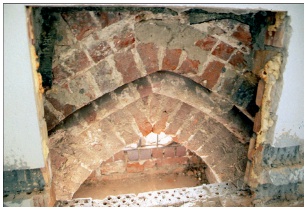
Abb. 5 Greifswald, ehemaliges Franziskanerkloster. Nordmauer im Erdgeschoss des heutigen „Konventshauses“. Profiliertes Bogenmauerwerk des ursprünglichen Chorsüdportals. Blick nach Norden. Foto: A. Lutze (2004)
