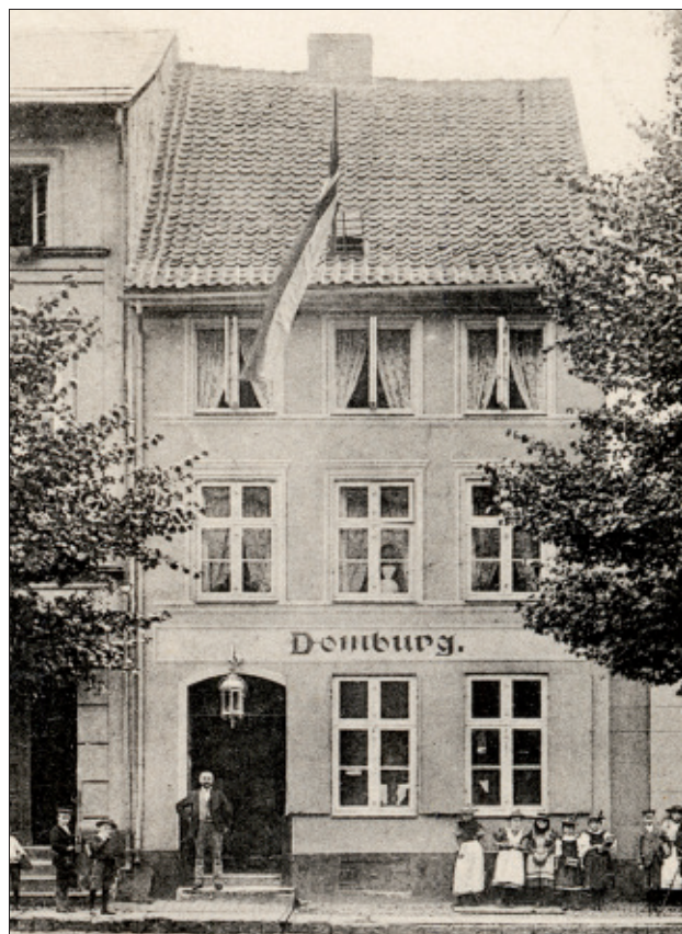
Abb. 12 Greifswald, Domstraße 21. Bei der Reparatur von 1822/1823 entstand die auf der Postkarte zu erkennende neue Putzfassade in klassizistischen Formen. Abbildung: Postkartensammlung W. Reiher
