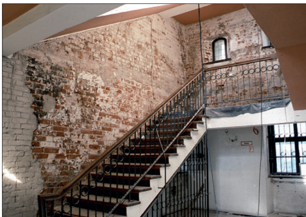
Abb. 13 Greifswald, ehemaliges Franziskanerkloster. Bibliotheksgebäude, Treppenhaus zwischen Erd- und Obergeschoss. In der Westmauer (links) und der anschließenden Nordmauer sind Teile eines zweigeschossigen Gebäudes von 1285/1290 erhalten. Das Fenster über dem Zwischenpodest markiert die Position des ehemals niedrigen Obergeschosses. Blick nach Nordwesten. Foto: A. Lutze (2003)
