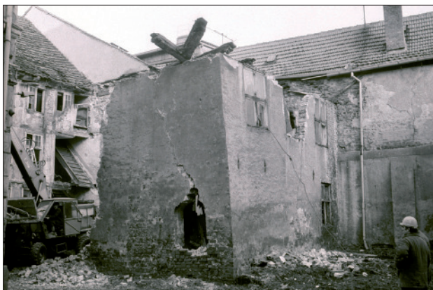
Abb. 8 Greifswald, Domstraße 21. Abbruch der Hintergebäude. An der Hoffassade des Vordergebäudes ist der Abdruck des Verbindungsbaues zu erkennen. Blick nach Nordosten. Foto: T. Rütz (1988)
