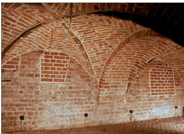
Abb. 14 Greifswald, ehemaliges Franziskanerkloster. Keller des „Konventshauses“. In der Westmauer sind Teile des Erdgeschosses des Klausur-Ostflügels aus der Zeit um 1290/1295 erhalten. Rechts neben der in der linken Bildhälfte erkennbaren neuzeitlichen Ausmauerung ist der Bogenansatz des Auflagers für eine geplante Kuppel einwölbung erhalten. Blick nach Nordwesten. Foto: A. Lutze (2003)
