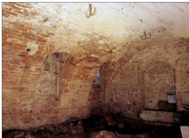
Abb. 16 Greifswald, Domstraße 21. Südliches Tonnengewölbe des Kellers. Die Einwölbung des ursprünglich mit Balken gedeckten Kellers entstand 1822/1823. Blick nach Südwesten. Foto: T. Rütz (2002)
