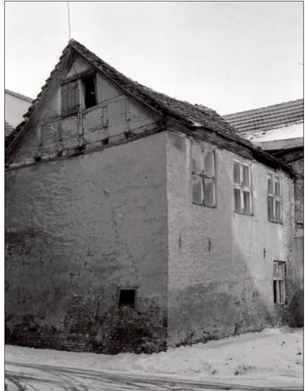
Abb. 7 Greifswald, Domstraße 21. Südwestecke des barocken Hintergebäudes. Im Obergeschoss befanden sich sehr wahrscheinlich die Bibliothek Dähnerts und die von ihm für Lehrveranstaltungen genutzten Räume. Blick nach Nordosten. Foto: T. Rütz (1987)
