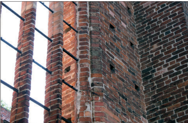
Abb. 11 Stralsund, Ruine der ehemaligen Franziskanerklosterkirche. Gewände eines südlichen Chorfensters. Die äußere Profilstufe wird durch einen seltenen Formsteintyp mit ungewöhnlich breiter Abfasung gebildet. Er fand auch beim Bau der Greifswalder Franziskanerkirche Verwendung. Blick nach Nordosten. Foto: A. Lutze (2012)
