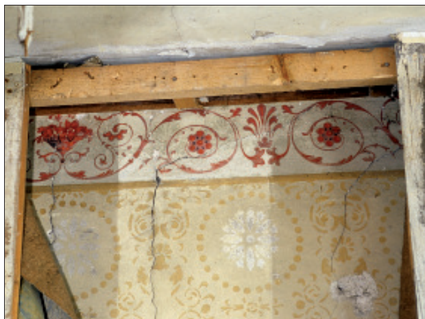
Abb. 17 Greifswald, Domstraße 21. Die klassizistische Wandgestaltung im straßenseitigen Raum des Obergeschosses entstand nach der Erneuerung des Westgiebels 1833/1834. Foto: T. Rütz (2002)
