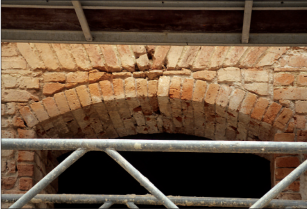
Abb. 13 Greifswald, Domstraße 21. Die barocke Haustüröffnung wurde beim klassizistischen Umbau etwas verkleinert und mit einem segmentbogigen Sturz versehen. Der ursprüngliche gerade Sturz ist darüber zu erkennen. Foto: T. Rütz (2002)
