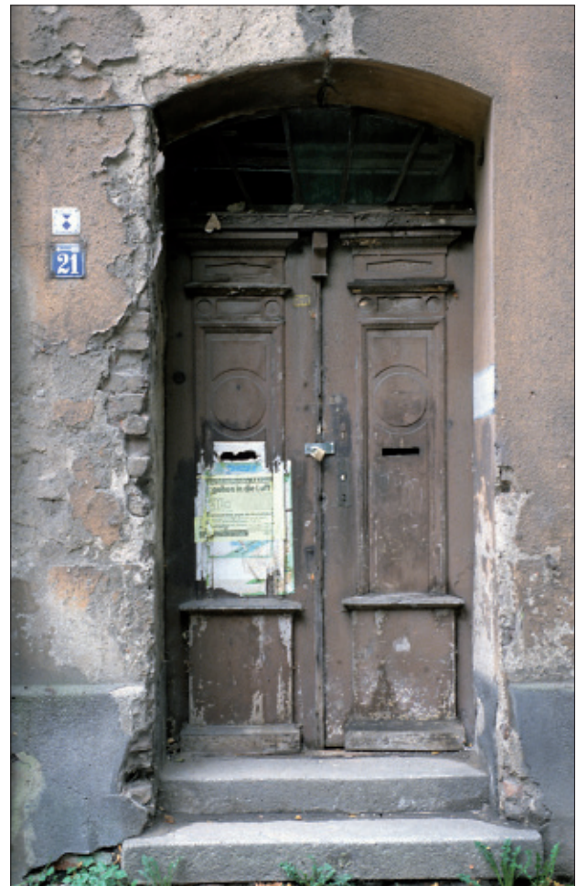
Abb. 14 Greifswald, Domstraße 21. Haustür von 1822/1823 mit schlichtem klassizistischen Dekor. Die Stufen wurden in der zweiten Hälfte des 19. Jahrhunderts in Granit erneuert. Foto: T. Rütz (1992)
