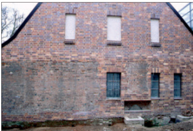
Abb. 4 Greifswald, ehemaliges Franziskanerkloster. Das in der Nordmauer des heute als „Konventshaus“ bezeichneten Gebäudes erhaltene mittelalterliche Backsteinmauerwerk gehörte ursprünglich zur Chorsüdmauer der Kirche. Blick nach Süden. Foto: A. Lutze (2001)
