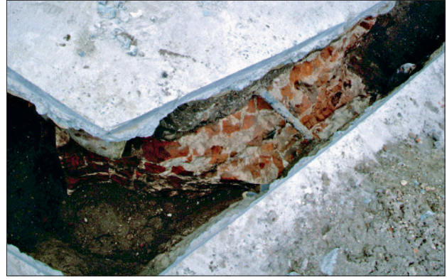
Abb. 12 Greifswald, ehemaliges Franziskanerkloster. Mühlenstraße 15 („Gemäldegalerie“), Mauerwerksbefund unter der südöstlichen Gebäudekante. Links der Ansatz des Chorpolygons von 1348 (?), rechts davon ein Ansatz des ursprünglichen polygonalen Abschlusses aus dem 13. Jahrhundert. Blick nach Nordwesten. Foto: A. Lutze (1999)
