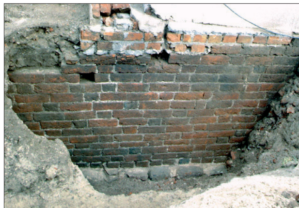
Abb. 7 Greifswald, ehemaliges Franziskanerkloster. Unter dem östlichen Seitenrisalit auf der Rückseite des heutigen Gebäudes Mühlenstraße 15 („Gemäldegalerie“) wurden Teile der einstigen Chornordmauer erfasst, hier unterhalb der westlichen Risalitekante. Blick nach Norden. Foto: A. Lutze (2003)
