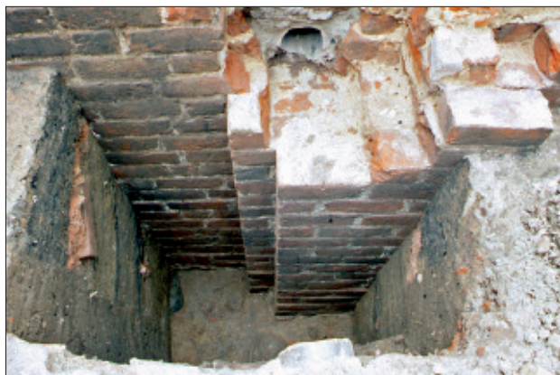
Abb. 9 Greifswald, ehemaliges Franziskanerkloster. Langhaus südlicher Klosterkirche mit einfach gestufter Wandvorlage (hier die östliche). Blick nach Süden. Foto: A. Lutze (2001)
