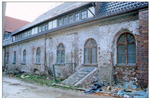
Abb. 17 Greifswald, ehemaliges Franziskanerkloster. Ostmauer des „Konventshauses“. Die vorhandenen Fenster markieren die Fensterpositionen des mit den Veränderungen um/nach 1300 entstandenen Erdgeschosses des östlichen Klausurflügels. Die nur noch partiell erhaltenen Strebe Pfeiler gehören in die gleiche Bauzeit. Blick nach Südwesten. Foto: A. Lutze (2003)
