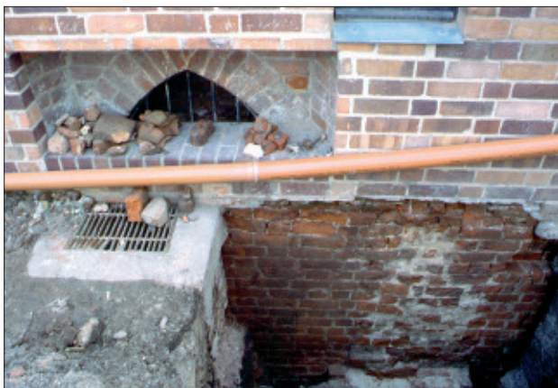
Abb. 6 Greifswald, ehemaliges Franziskanerkloster. Nordmauer des heutigen „Konventshauses“. Westlich der mittelalterlichen Zusetzung des ursprünglichen Chorsüdportals wurde die Abbruchspur (rechts unten) des ursprünglich den Chor und das Langhaus trennenden Triumphbogens freigelegt. Blick nach Süden. Foto: A. Lutze (2003)
