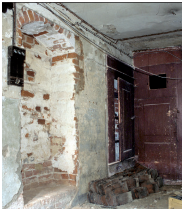
Abb. 9 Greifswald, Domstraße 21. Hausdiele des Erdgeschosses. In die hintere Nische der mittelalterlichen Brandmauer wurde ein barocker Wandschrank eingebaut. Rechts daneben ist die Verkleidung der Haustreppe mit einem barocken Türblatt zu erkennen. Blick nach Südosten. Foto: T. Rütz (1997)
